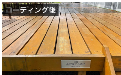
コーティング後 ウッドデッキへの施工例（塗工後）
