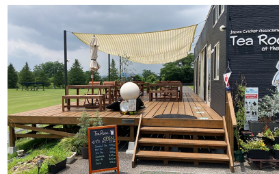
ウッドデッキへの施工例（全体）
