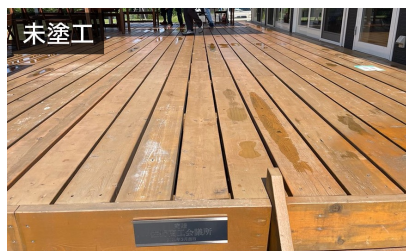
未塗工 ウッドデッキへの施工例（未塗工）
